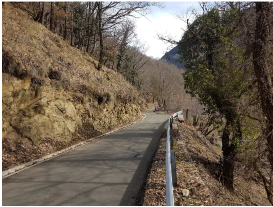
Imatge 01. Estat actual de la carretera de Canejan (del pk 0+450 al pk 0+500)
