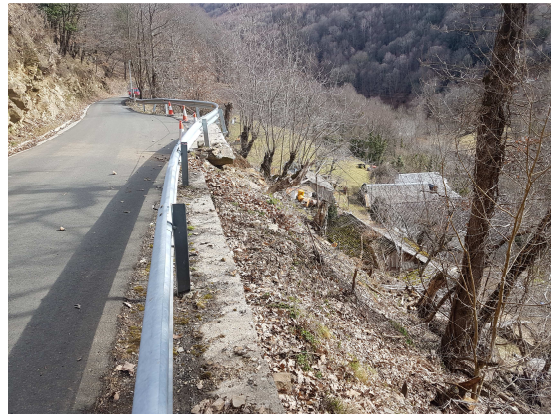
Imatge 02. Estat actual de la carretera de Canejan (del pk 0+450 al pk 0+500)
