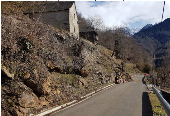
Imatge 03. Estat actual de la carretera de Canejan (del pk 1+323 al pk 1+343)
