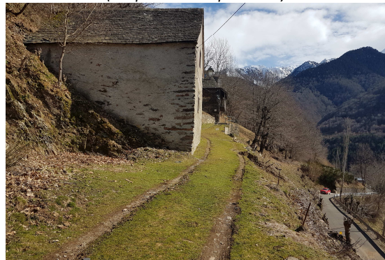
Imatge 04. Estat actual de la carretera de Canejan (del pk 1+323 al pk 1+343)
